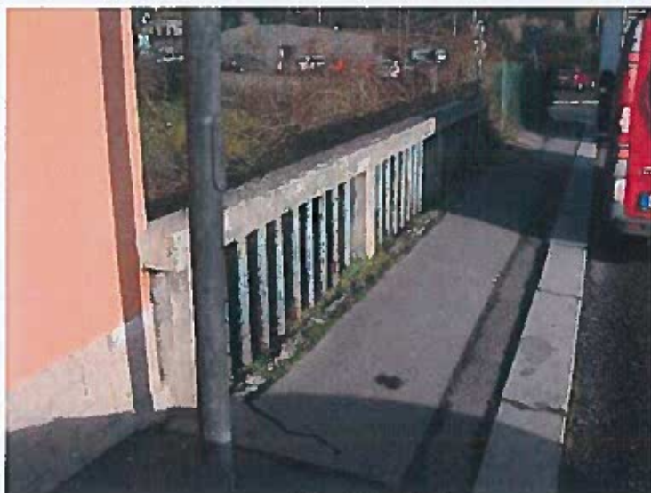
Chodník, římsa a zábradlí na vtoku
