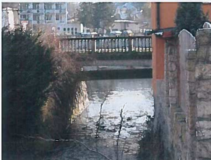
Pohled na vtok
