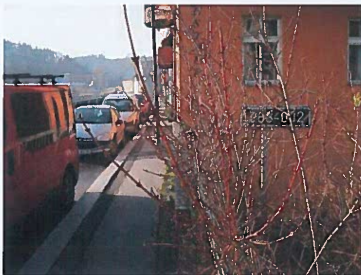
Chodník, římsa a zábradlí na vtoku
