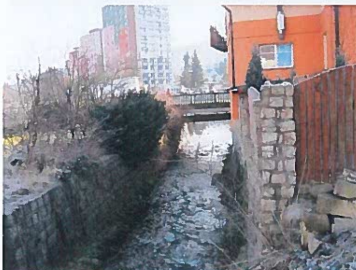
Pohled na vtok
