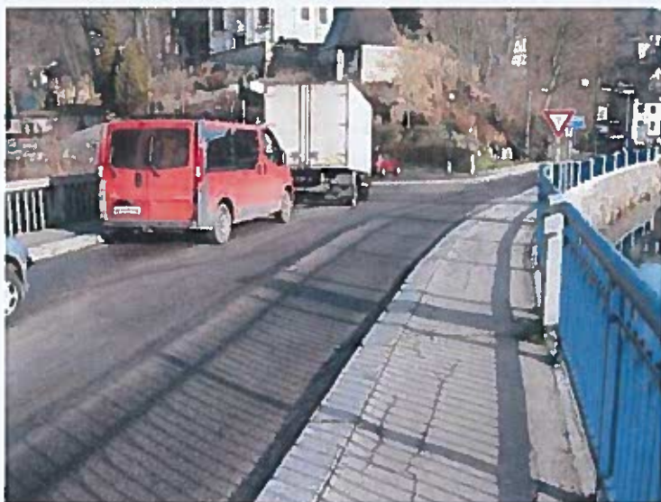
Pohled ve směru staničení
